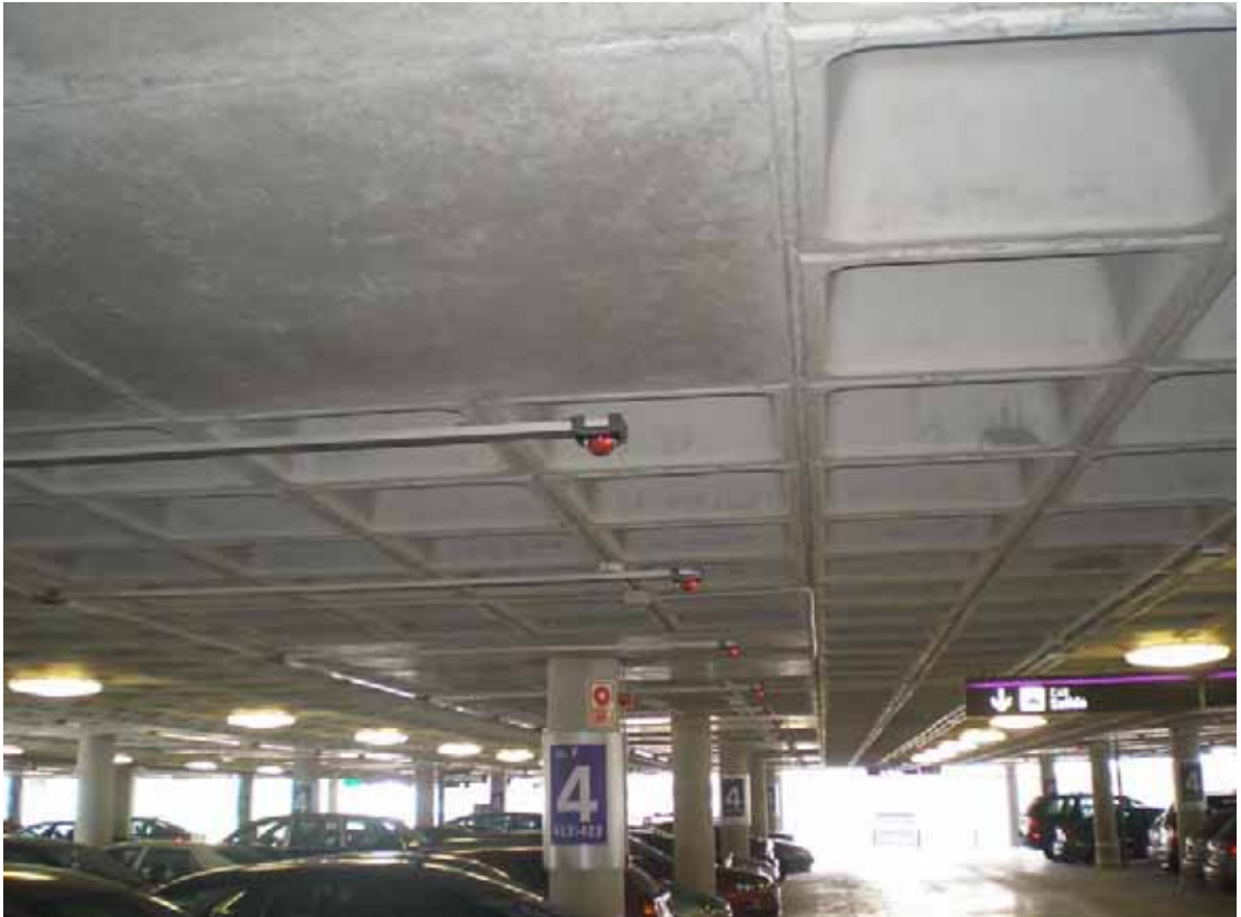
Foto 8. Indicador Luminoso en Parking.
