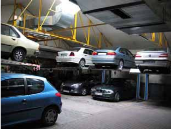
Figura 14. Implantación de un sistema Parklift en un aparcamiento existente.
