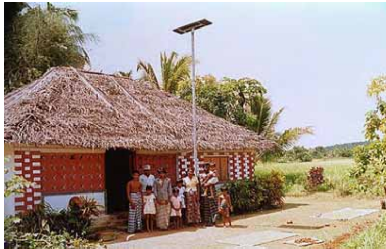
Foto 1. Instalación fotovoltaica aislada.
