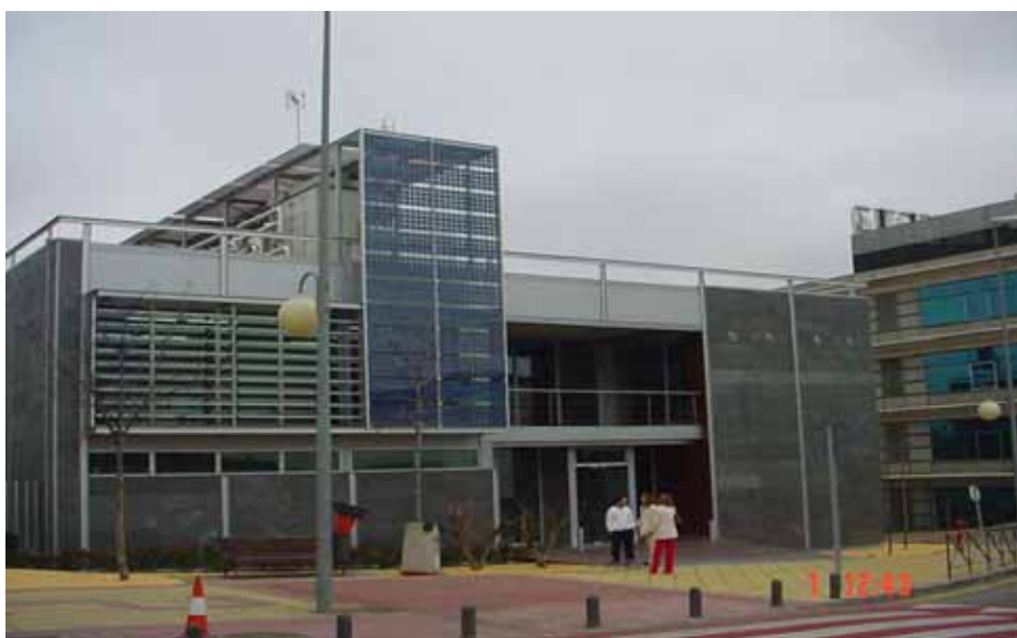
Foto 8. Instalación fotovoltaica integrada en muro cortina.
