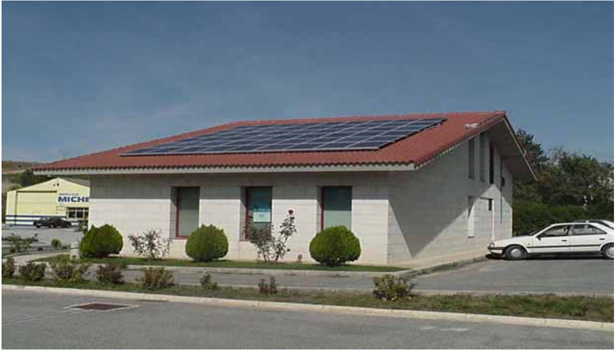
Foto 3. Sistema fotovoltaico sobre tejado inclinado.
