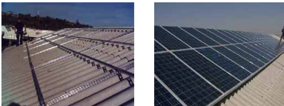
Foto 4. Estructura sobre tejado inclinado de uralita.
