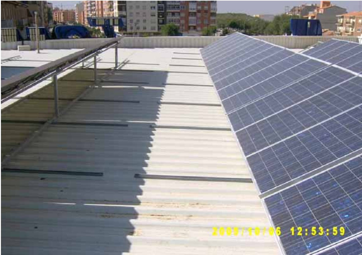
Foto 5. Estructura sobre tejado plano de uralita.
