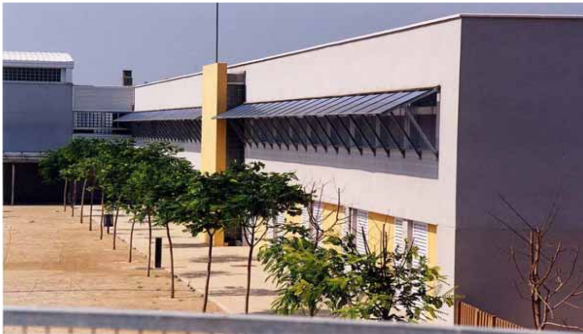
Foto 11. Instalación fotovoltaica integrada en parasoles.
